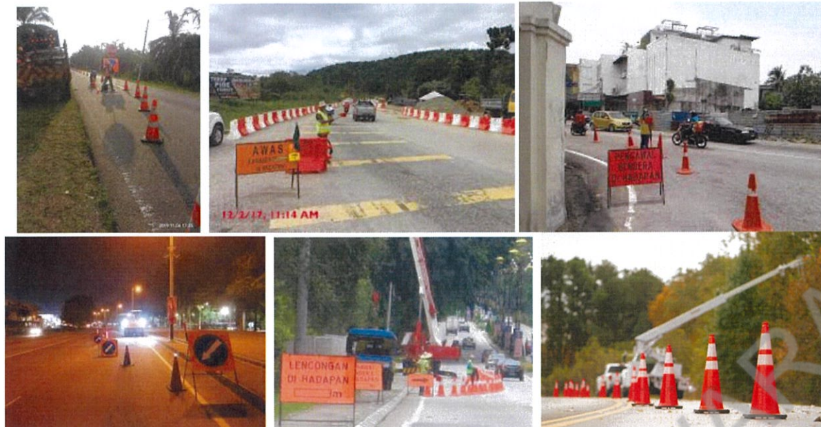
1.3 Contoh kawalan keselamatan dan lalu lintas di tapak
